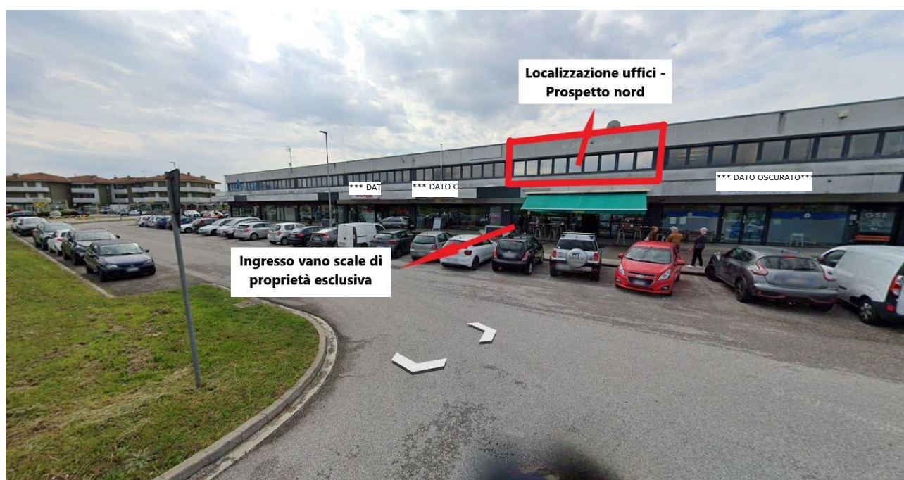
Prospetto Nord fabbricato condominiale - fronte strada Via C. Nanino
