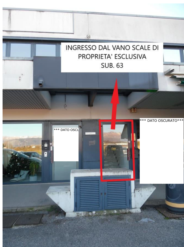
Ingresso – vano scale – p.T
